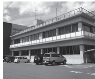
▲立田支所の解体部分
